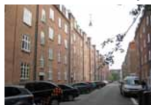
Grundmurede facader i Lundbygsgade.
