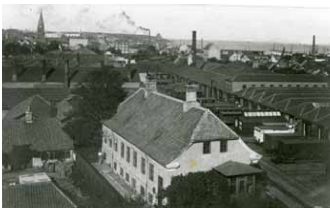
Den gamle Jægergård i forgrunden, omgivet mod nord og øst af Centralværkstedets omfattende bebyggelse og rygende skorstene.
